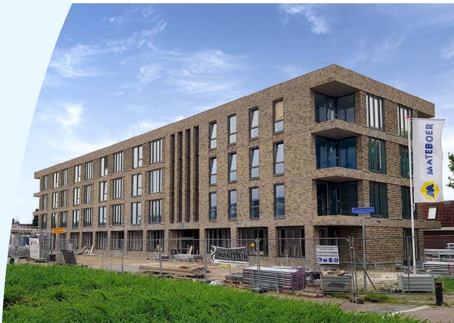
Blok 1 nieuwbouw Drostenstraat
